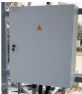
Рис. 1.13. Окрема шафа для контролю та розподілу живлення
