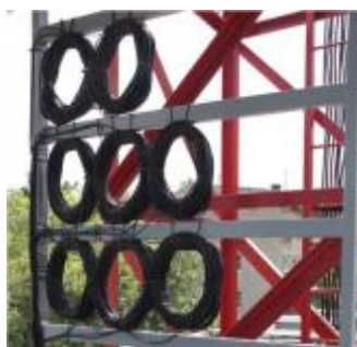
Рис. 1.16. Бухти оптоволоконного кабелю для з'єднання системних модулів
