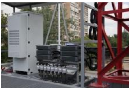
Рис. 1.12. Приклад розміщення обладнання для outdoor
